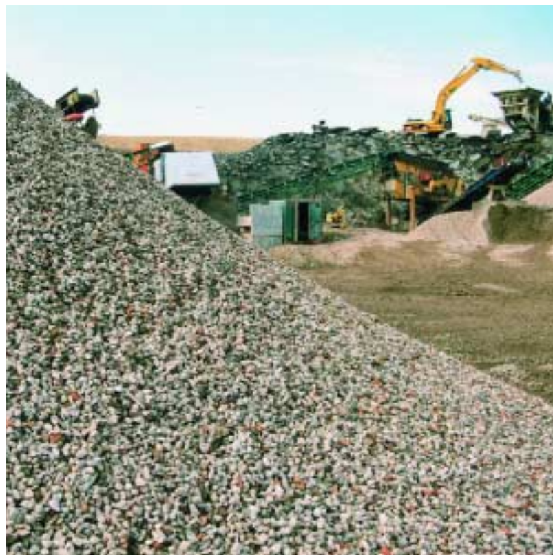
BA Gjenvinnings anlegg på Grønmo i Oslo
