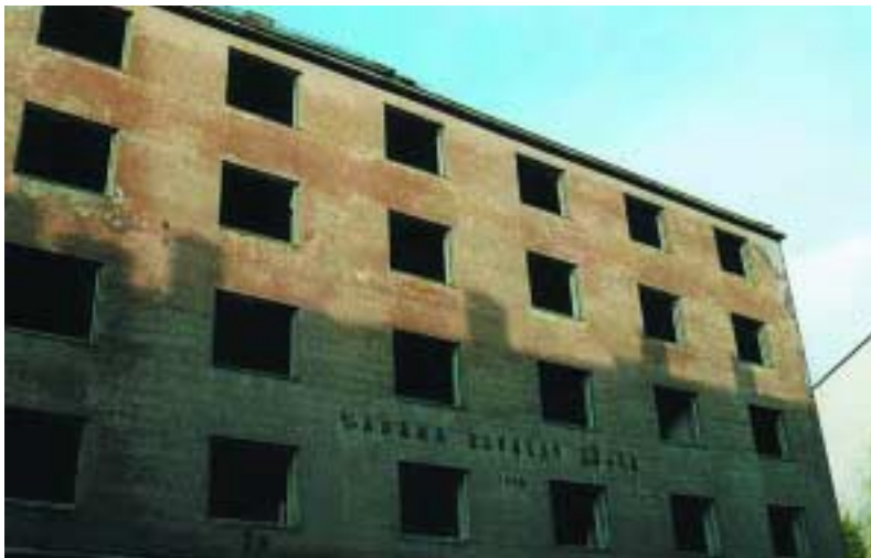
Bygg som er ferdig miljøsanert
